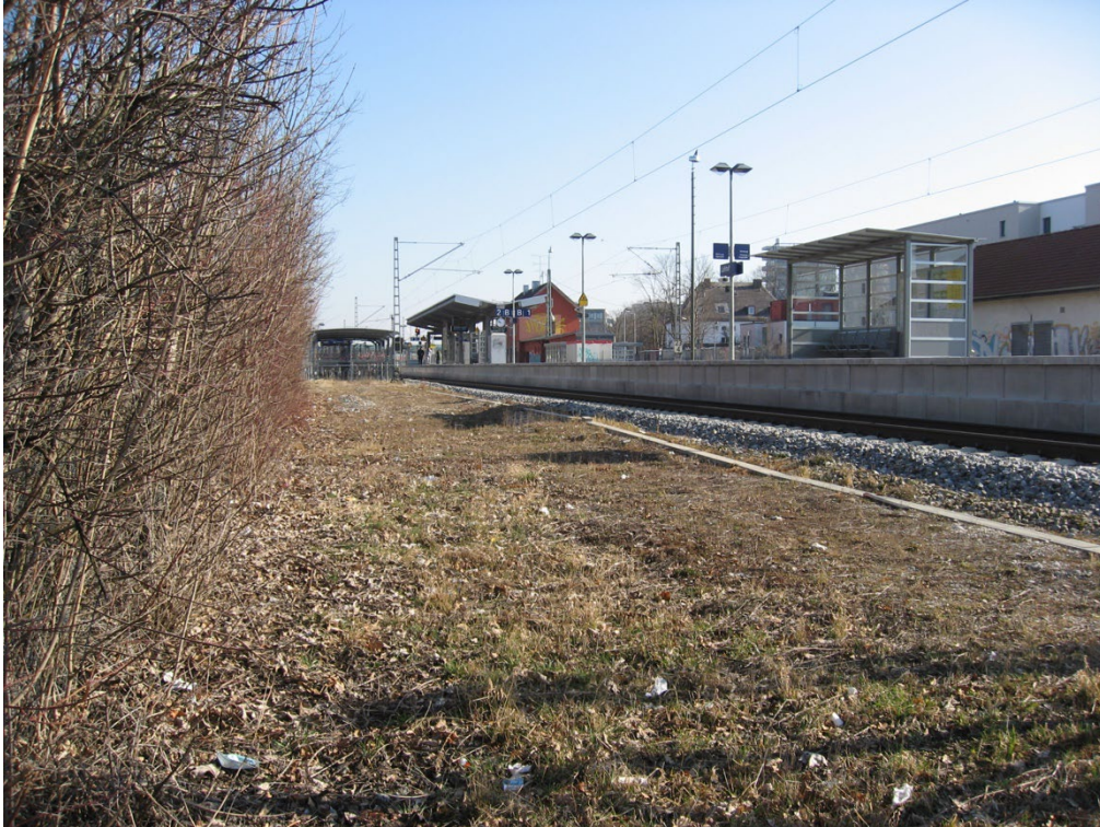
Abbildung 7: S-Bahngleise (rechts) und Plangebiet (links), getrennt durch einen ca. 5 m breiten Wiesenstreifen.
