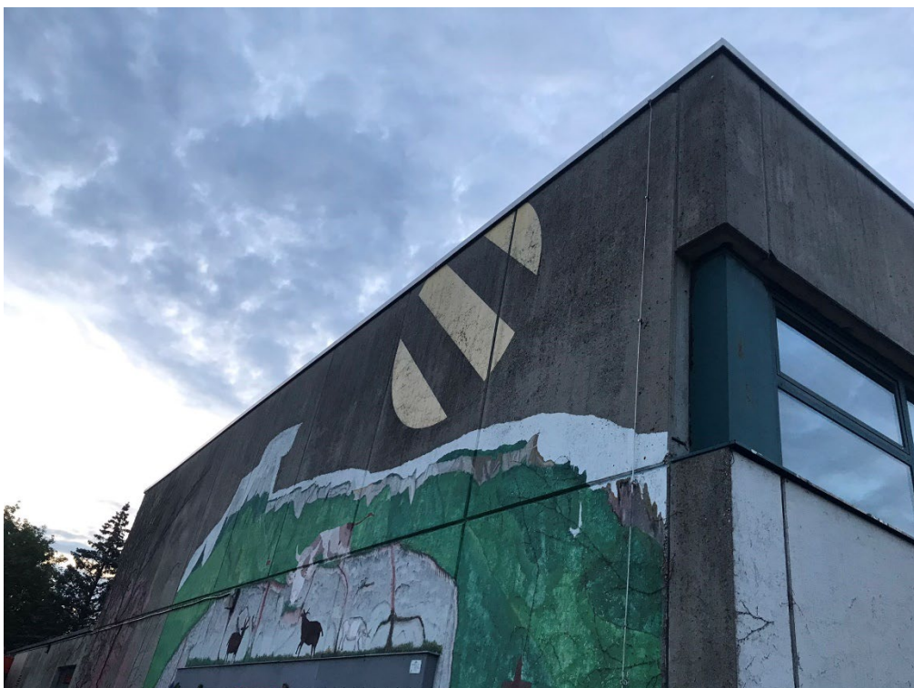
Abbildung 2: Westfassade der Turnhalle.
