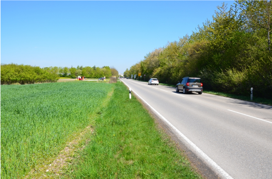
Die Landshuter Straße im Osten des Plangebiets. Rechts die dichte Gehölzhecke mit Lärmschutzwall
